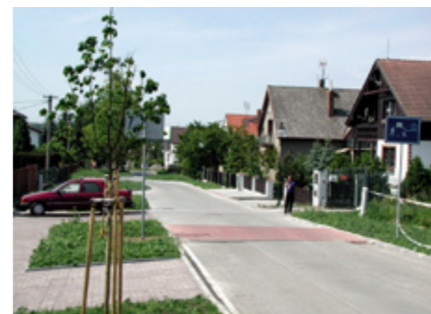
Obr. 15: Obytná zóna Plzeň-Bručná
