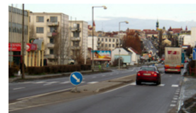
Obr. 20 a 21: Zúžení místní komunikace rozšířením chodníkové plochy v České Lípě (vlevo) či vložением středního dělicího ostrůvku ve Znojmo (vpravo)
