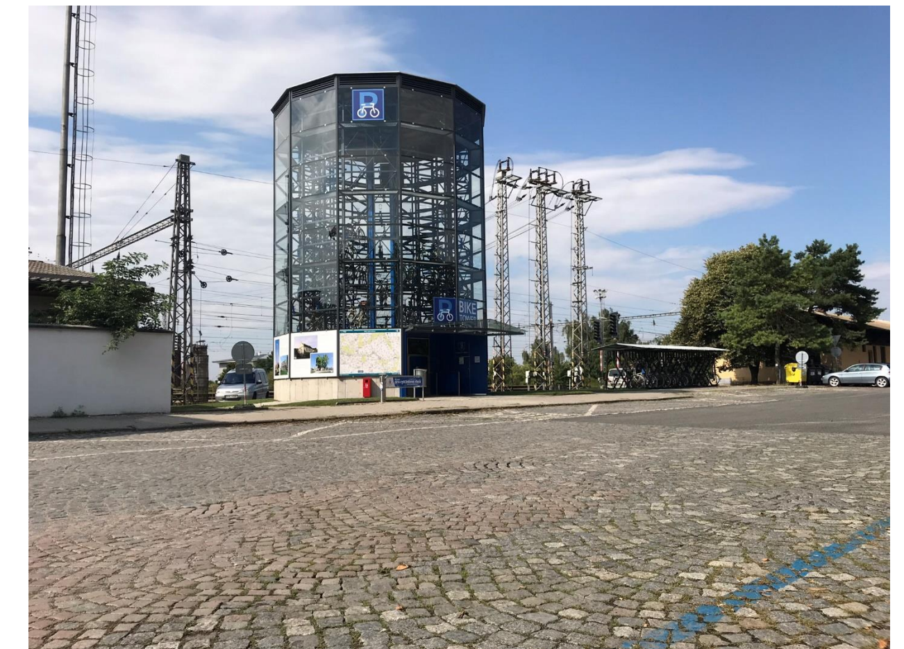
BIKETOWER BT 2.1 Lysá nad Labem vlakové nádraží Realizace 2017
