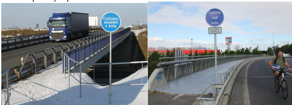
Obr. 1 Příklady neřešení cyklistické dopravy při rekonstrukci / výstavbě mostů (foto: T. Cach)
