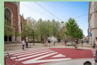
Künftig haben Radfahrerinnen und Radfahrer eine fünf Meter breite Fahrbahnfläche zur Verfügung. Wiedergabe: DLR/DA
