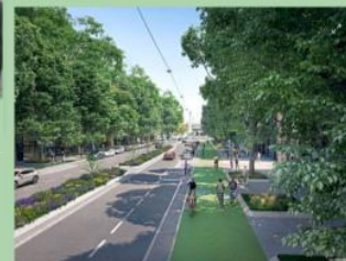
Die Praterstraße wird ab dem Sommer zur Baustelle. Wiedergabe: DLR/DA
