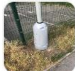
■ Oprava krytu veřejného...
