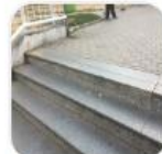
■ Oprava vysunutého panelu u...
